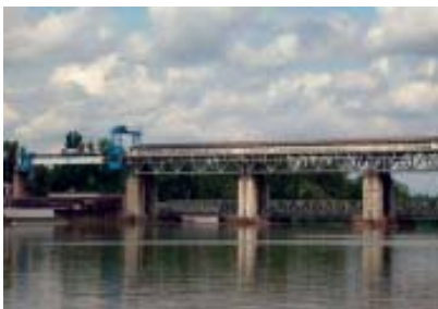
Wasserkraftwerk Kembs am Oberrhein.
