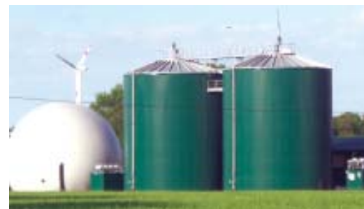
Die Biogasanlage in Steinfurt.
