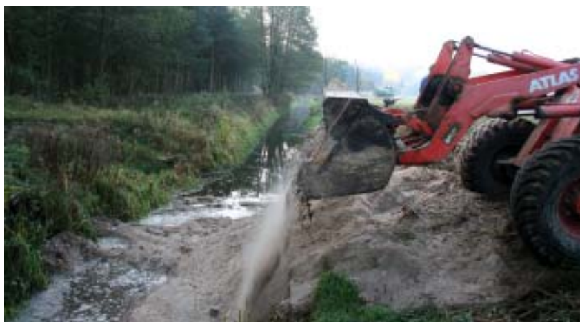
Der zum Kanal verbaute Zehrengaben wird wieder zugeschüttet.
