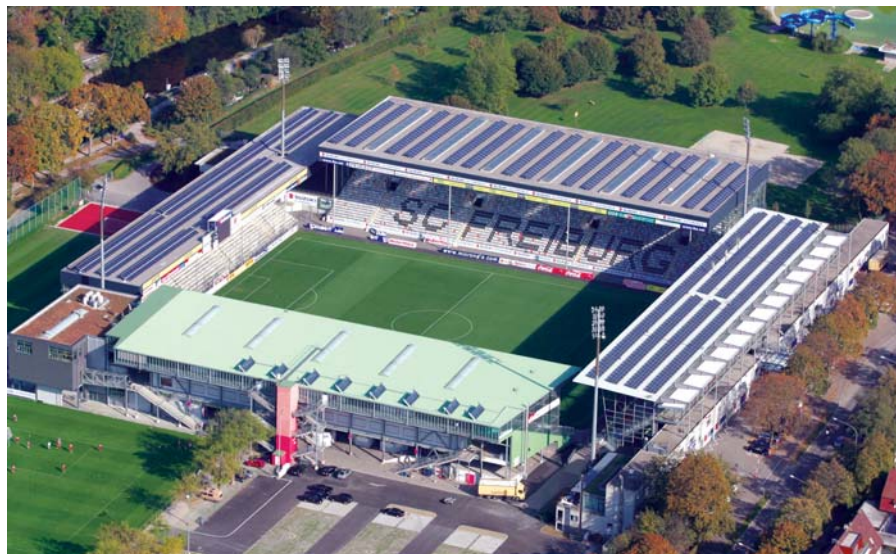
Die Photovoltaikanlage auf dem badenova-Stadion liefert so viel Strom, wie der Freiburger Sportclub verbraucht.
